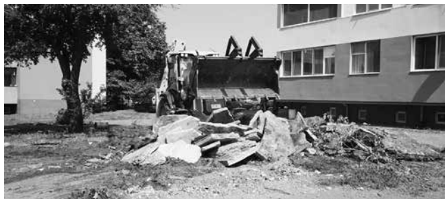
Разчистиха постаментите от бетон, върху които бяха поставени гаражите
