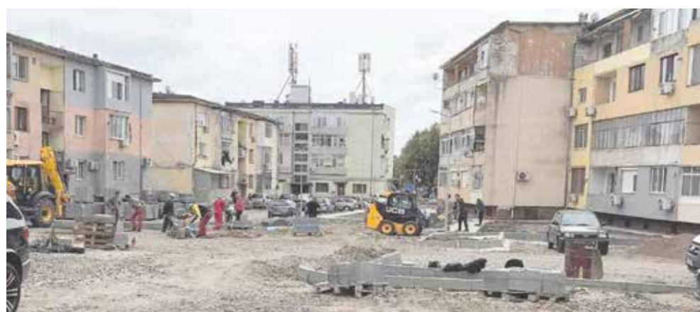
Квартал 49 е строителна площадка
