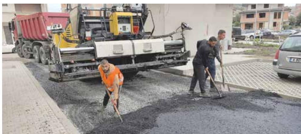
Асфалтиране в кв. 154
